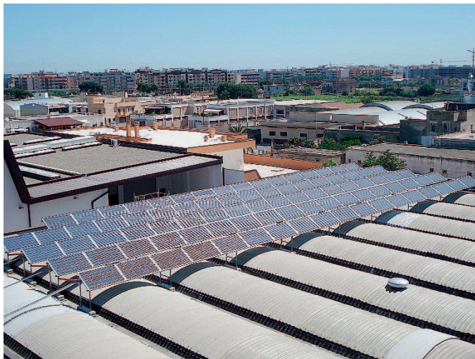
ENERGIA PULITA I pannelli fotovoltaici sul tetto dell'azienda
